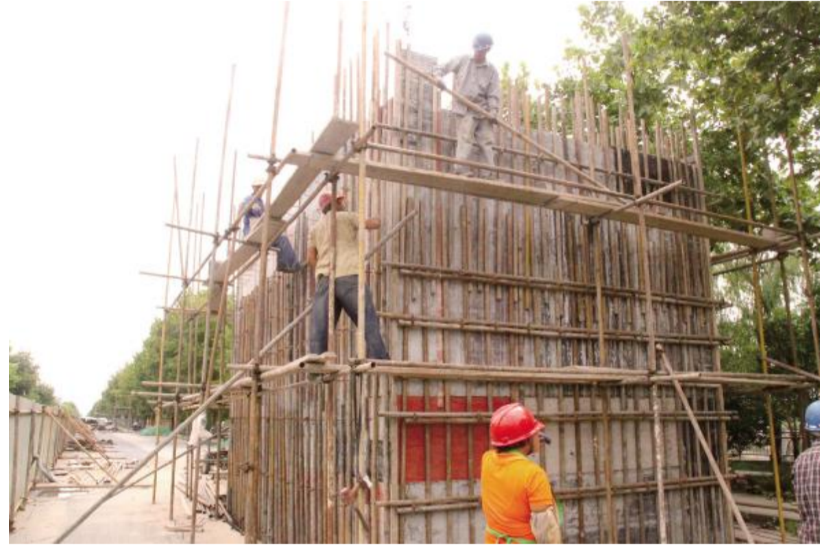
年初以来,我县组织实施小洋河污水截流工程,通过沉井法和顶管技术,将生活污水截流至污水管道内,阻止其向小洋河排放。小洋河污水截流工程西起合兴桥,东至黄海桥,总长4.65公里,投入资金2251万元,目前该工程已全部进场施工。图为双山路到振阳街段沉井制作现场。 周蓉蓉 摄
