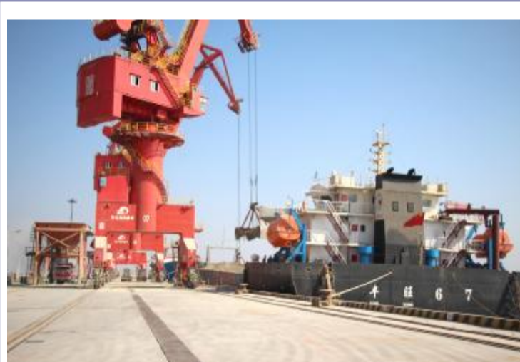
繁忙的射阳港口码头
