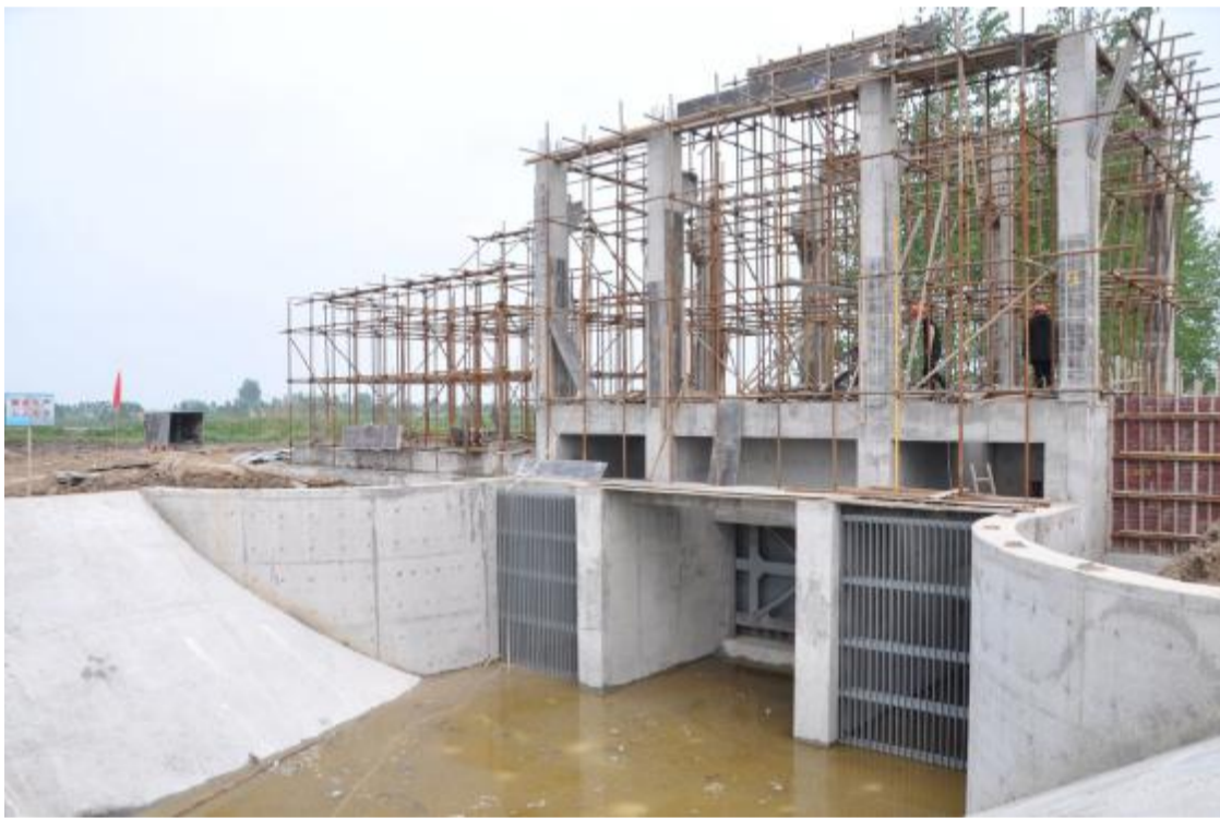
连日来,县水利工程建设处通过强化一线监督管理,着力保障在建水利工程进度与质量。图为五岸灌区续建配套与节水灌溉泵站工程正在紧张实施,确保今年汛前竣工投入使用。 郭开国 摄
