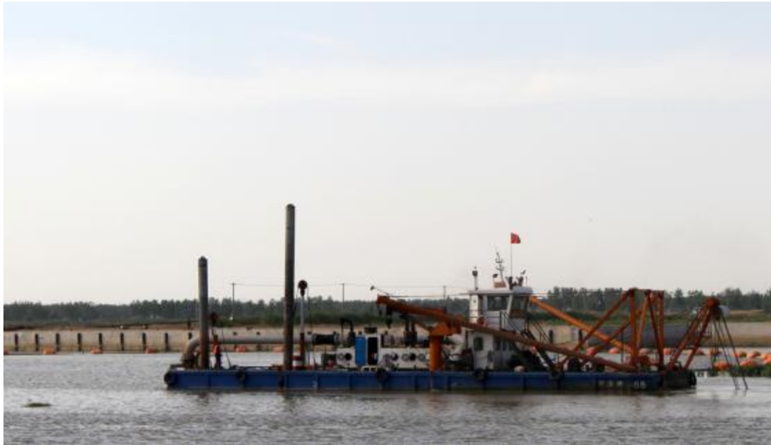
今年以来,黄沙港镇以建设江苏沿海重要渔港为目标,全力推进总投资5000万元的渔港二期工程。目前,150米长的上岸码头,550米长的系泊岸线已全部竣工,70万立方米的清淤工程已完成30多万立方米,预计整个工程6月份交付使用。图为清淤工程船正在抓紧施工。 王荣 摄
