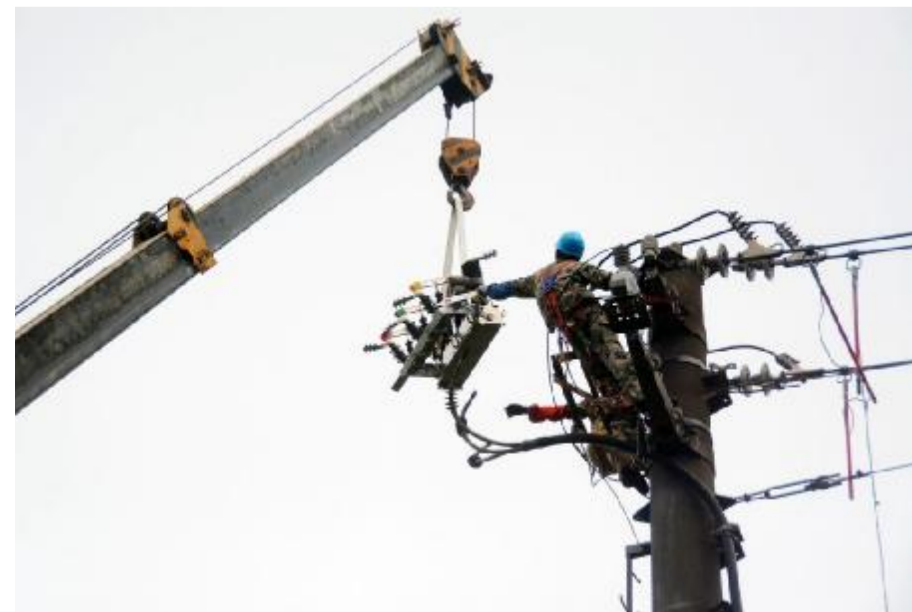
近日,县供电公司五支施工队伍在县沿河路10千伏沿河线各点同步开展作业,将老式的柱上断路器更换为新式智能断路器,进一步提高射阳电网智能化水平,为周边企业和居民用电提供坚强保障。 王楠 刘朋 摄
