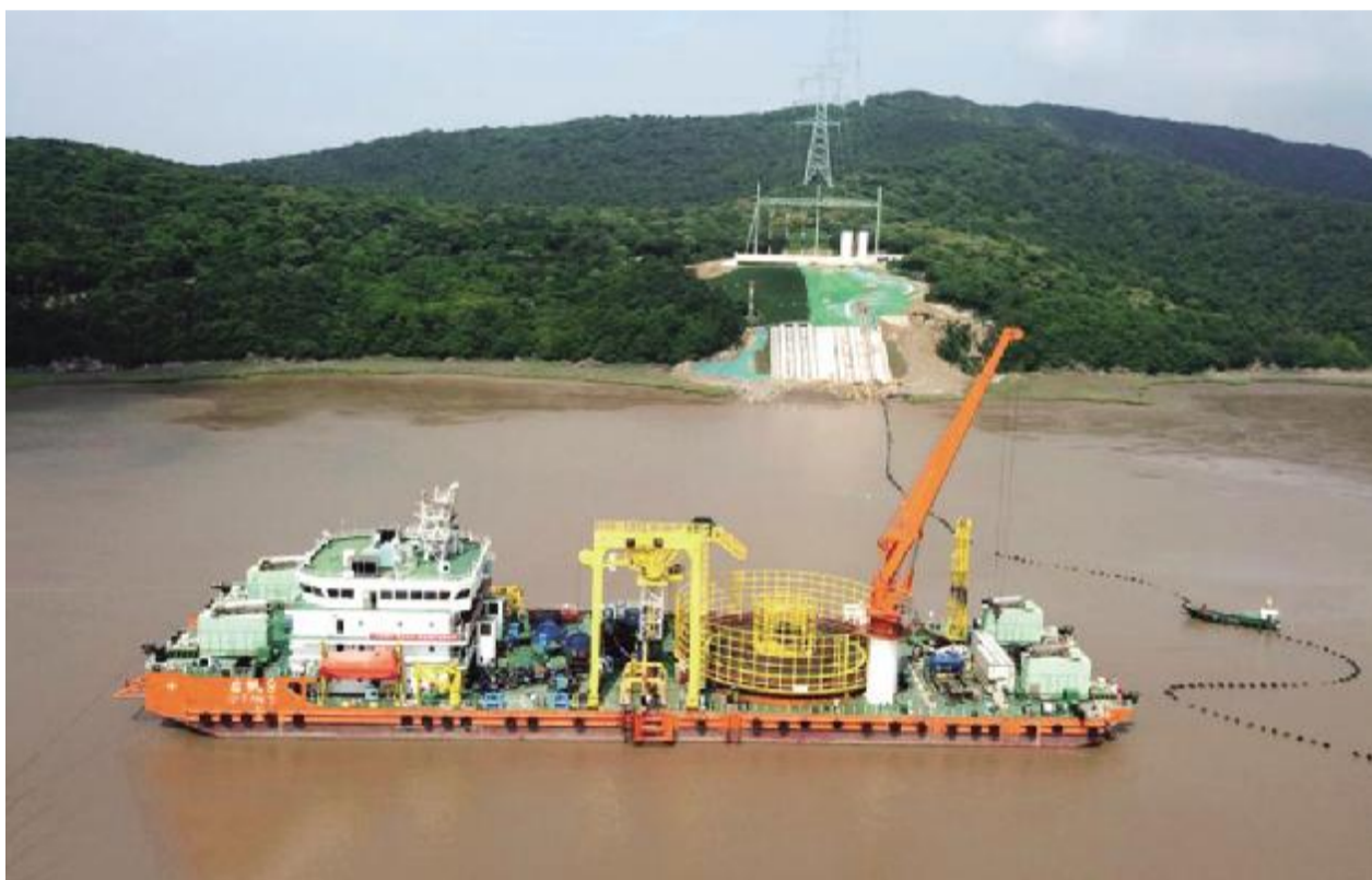
2019 年 6 月 2 日，最后一根 500 千伏海底电缆成功登陆陆山岛，标志着世界首个 500 千伏交联聚乙烯海缆建设工程顺利完工。
