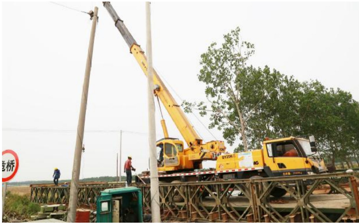
近年来,我县高度重视农村基础设施建设,强势推进农村路桥、康居工程的建设,农民获得感、幸福感持续提升。图为淮海农场路桥建设现场。 盛诚 彭岭 摄
