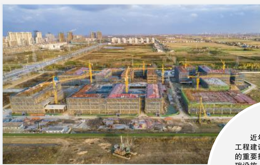
正在新建的新城小学
