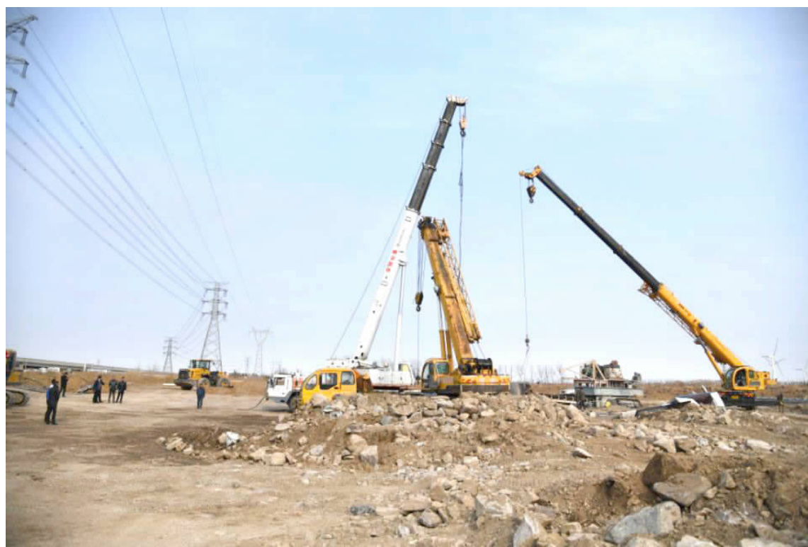
连日来,我县从强化责任和严格考核入手,加大河道沿岸“两违”整治力度,确保全面完成全年目标任务。图为河湖“两违”整治人员正在射阳河下游区域清理违建废弃物。郭开国 摄
