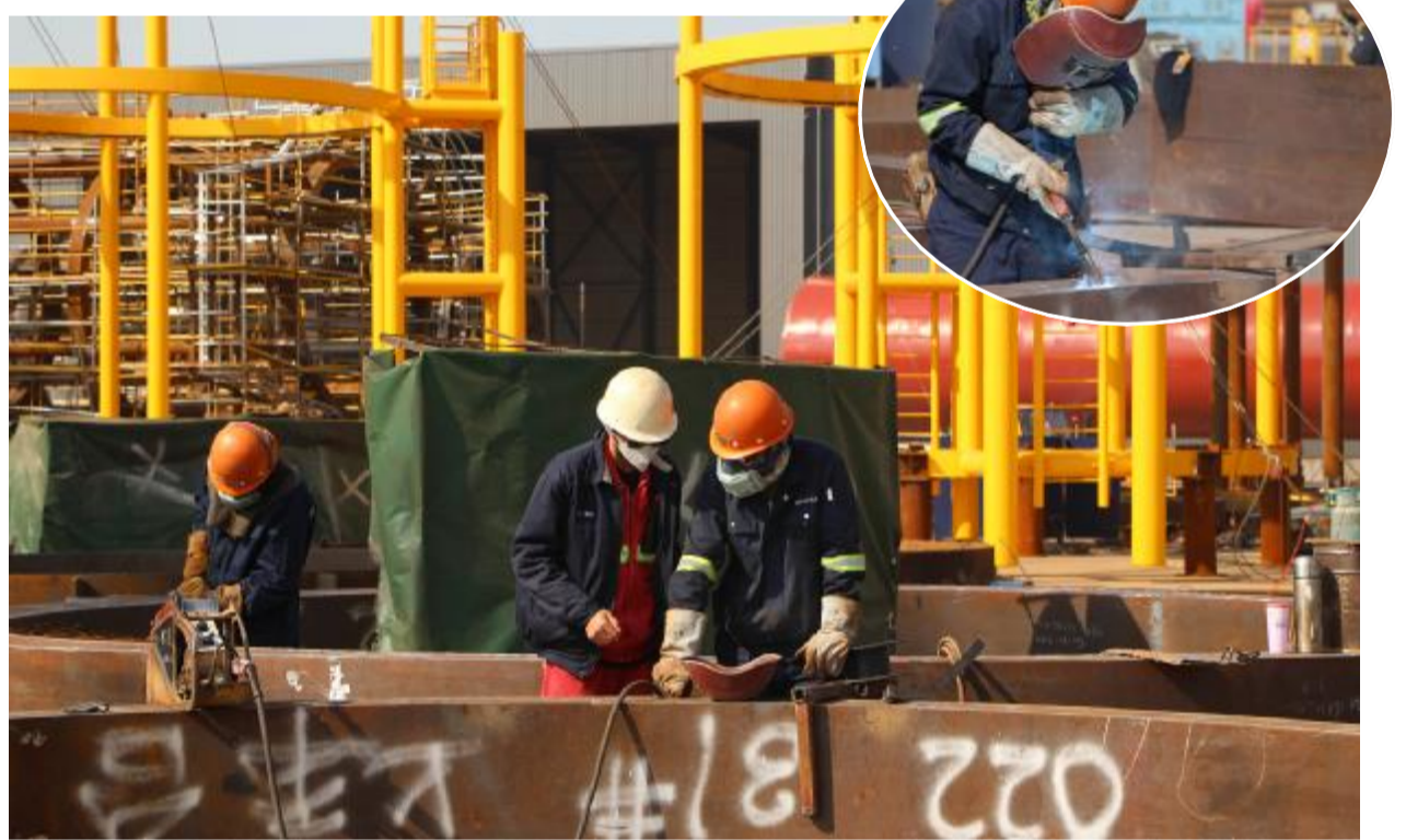
位于射阳经济开发区的江苏长风海洋装备制造有限公司是一家专业从事海洋风电塔架、钢管桩等海洋工程装备制造的大型企业。自2月12日复工以来,该公司全力协调生产要素,认真落实防疫措施,奋力冲刺首季“开门红”。图为该公司火热的生产场景。 王中印 摄
