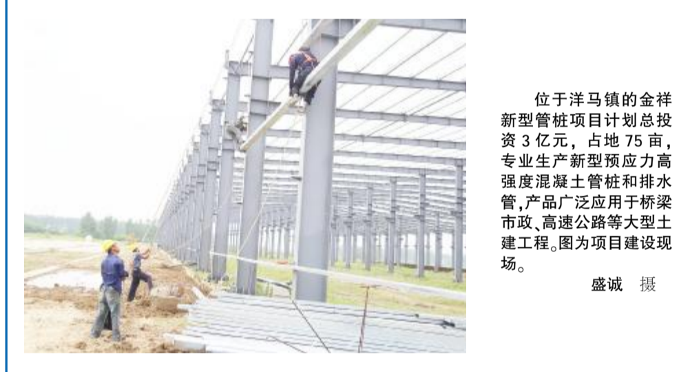
位于洋马镇的金祥新型管桩项目计划总投资3亿元,占地75亩,专业生产新型预应力高强度混凝土管桩和排水管,产品广泛应用于桥梁市政、高速公路等大型土建工程。图为项目建设现场。 盛诚 摄
