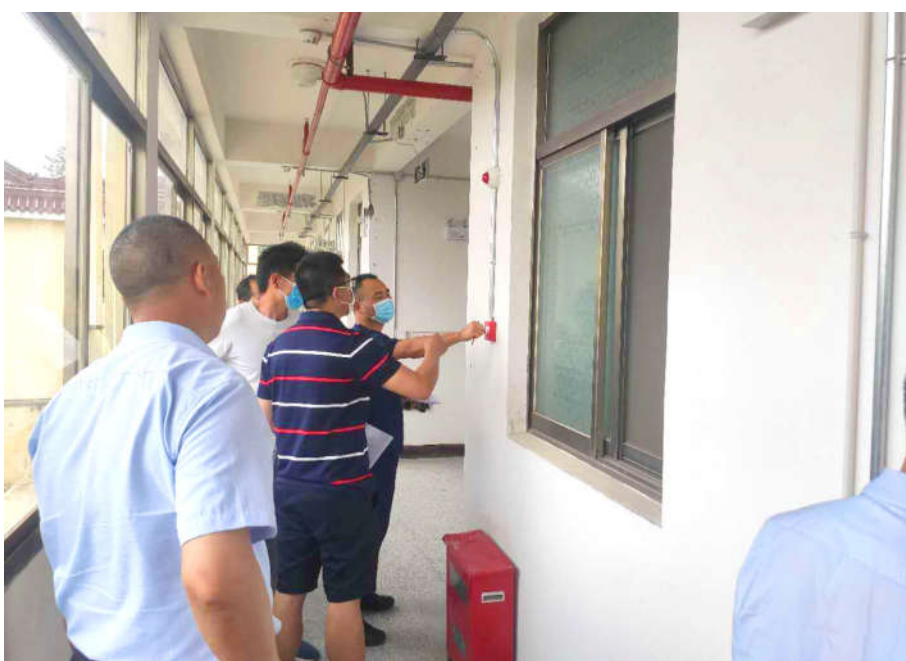
为贯彻落实关于安全生产的相关要求,6月份以来,县民政局精心筹划、合理安排、精心组织,深入开展安全排查工作。图为该局于日前邀请第三方到镇区养老机构进行消防验收。
