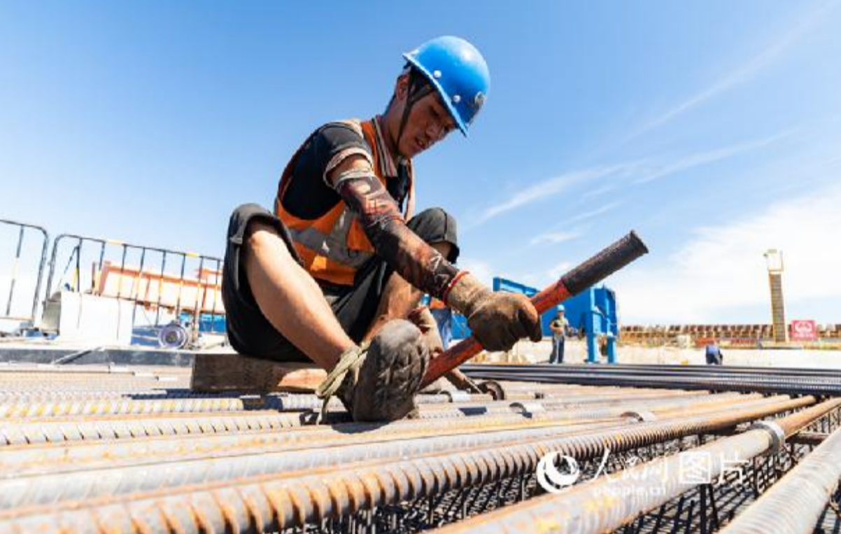
8 月 13 日，位于江苏省无锡市境内的苏锡常太湖隧道工程施工现场，工人们冒着酷暑高温，抢抓施工进度，加快隧道主体工程建设。据了解，苏锡常太湖隧道全长 10.79 公里，是国内在建最长水下隧道工程。该项目既是国家发改委和交通运输部确定的支撑“三大战略”发展的地方高速公路项目，也是江苏省“十五射六纵十横”高速公路网规划中“十五射”的重要组成部分。项目建成后将有有力沪宁通道作为国家综合运输大通道的功能作用，对促进沿线苏锡常城市发展，加快推动长三角一体化具有重要作用。
