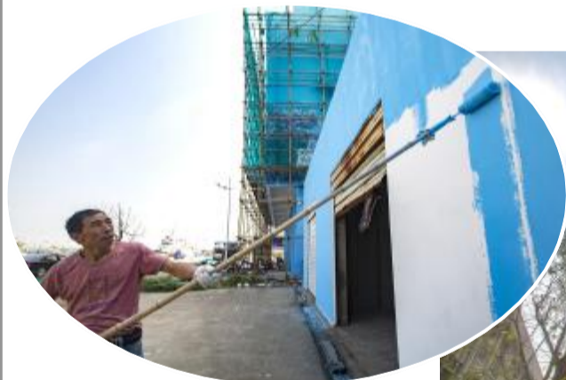
渔港码头楼宇装潢进行中
