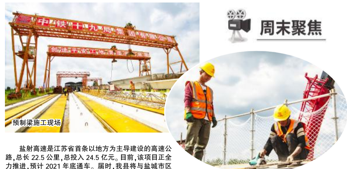
铺路架桥工作稳步推进
