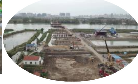
射阳主跨最大的合海线射阳河大桥正在施工
