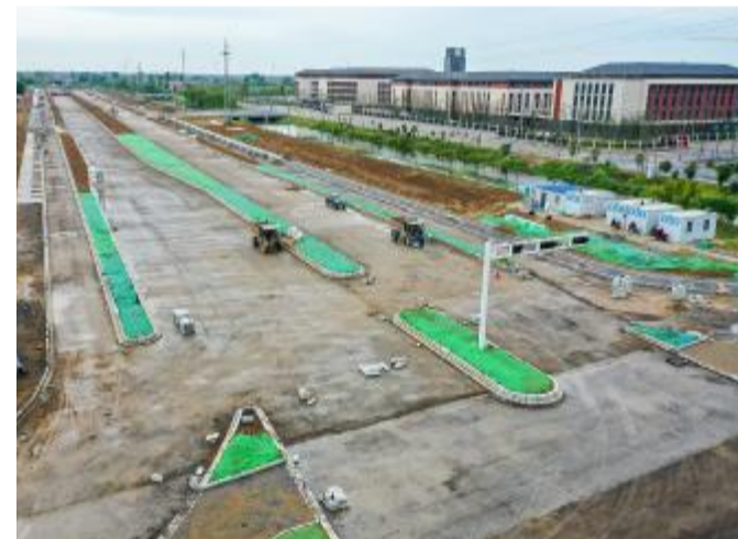
新城大道南延工程快速推进
