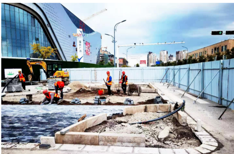
实施渠化改造工程
