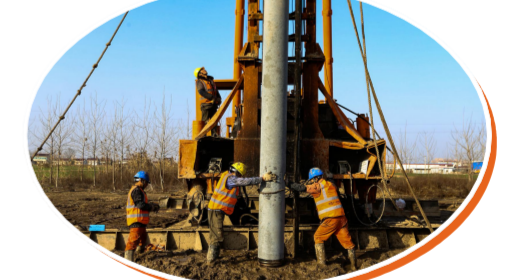
预制管桩静压施工现场
