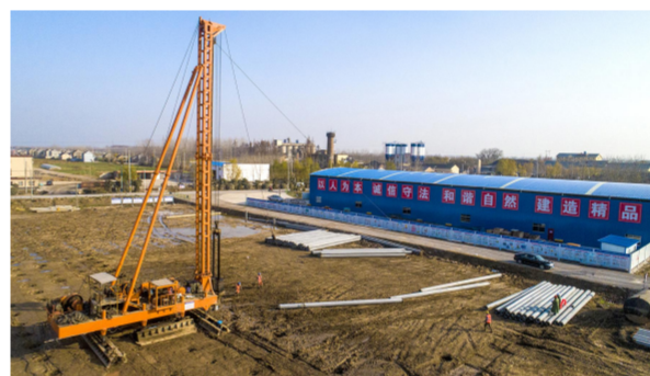
预制管桩锤击施工现场
