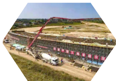
合德互通C匝道现浇箱梁浇筑施工现场
