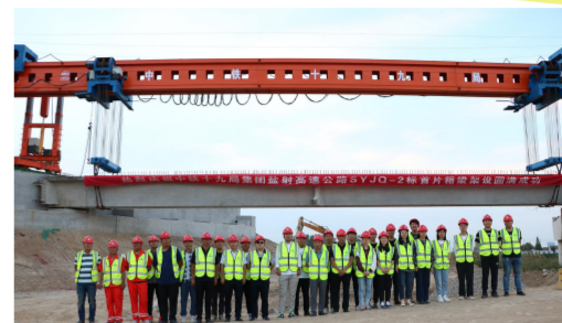
运棉河大桥首片箱梁架设现场
