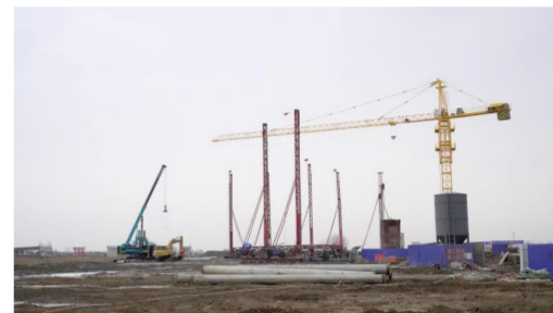
水泥搅拌桩施工现场
