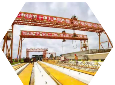
3SYJQ-2标板梁预制厂施工现场
