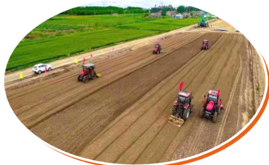
路基土方翻晒施工现场
