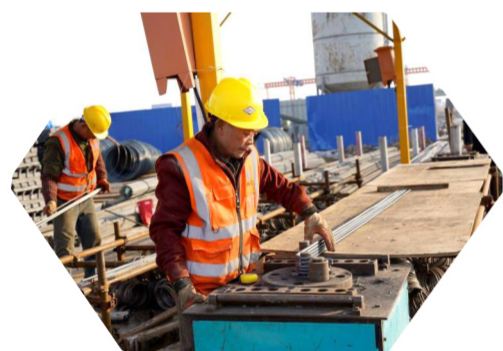
房建区钢筋制作现场
