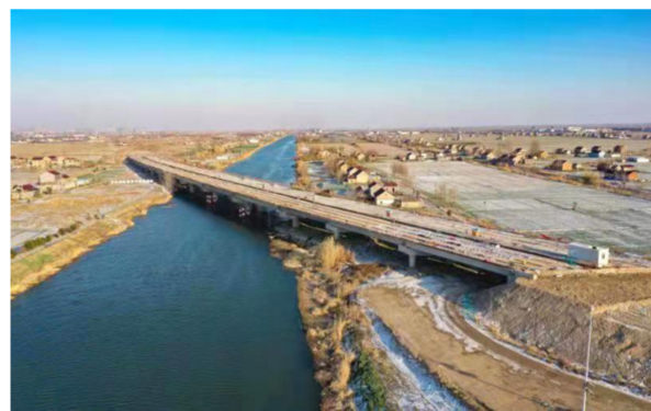
运棉河大桥预制箱梁全部架设安装完毕
