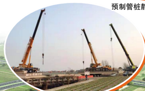
曙光河中桥空心板梁架安装现场
