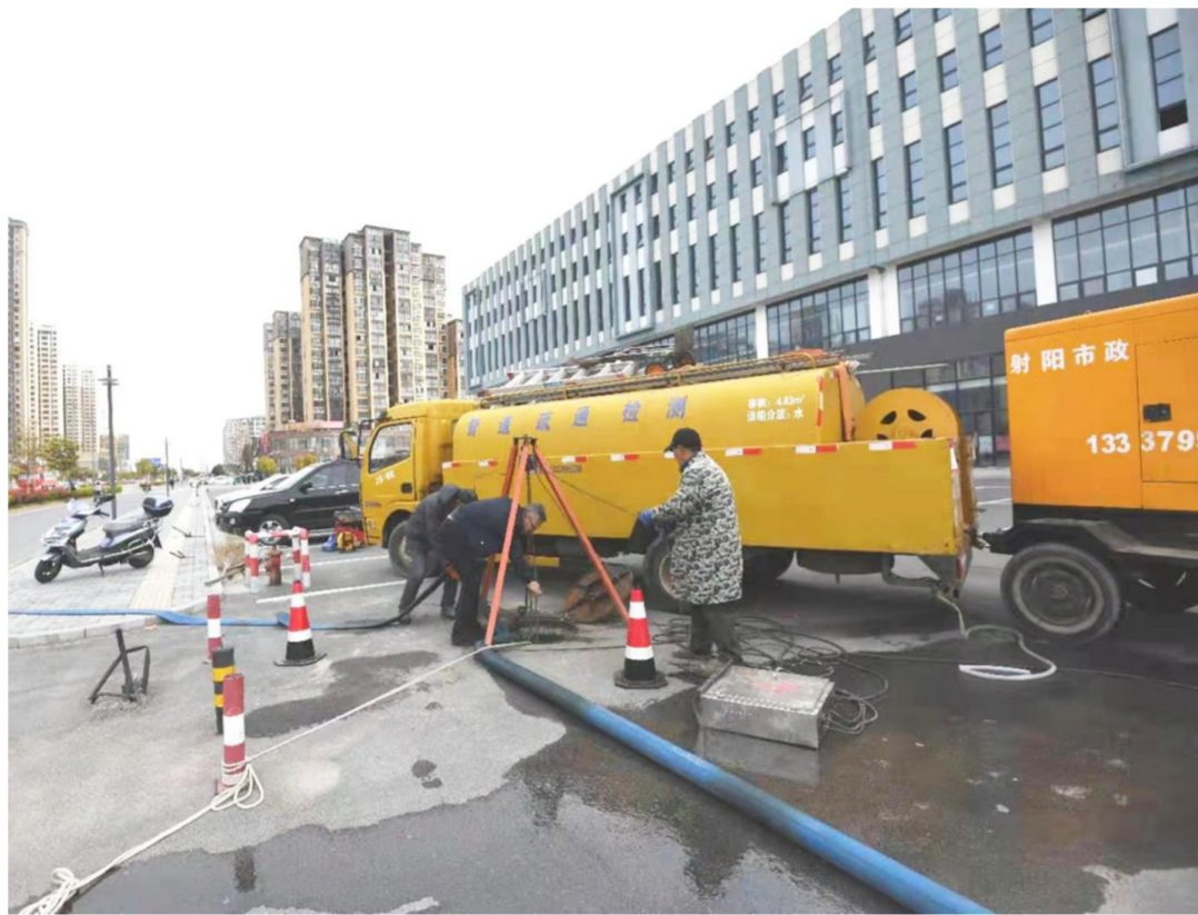
春节前夕,县城建管理部门未雨绸缪,对县城区交通道路、地下管网、通信杆线等市政设施破损、堵塞等进行全面检查维护,确保节日期间安全优质运行。图为县市政部门在对县城主干线路地下排水管网进行清理。
