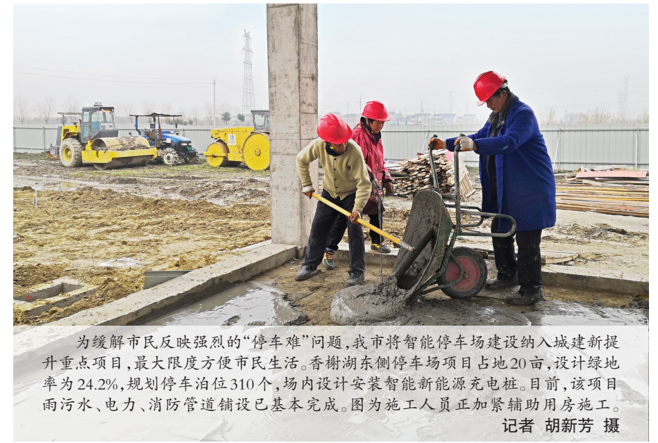
为缓解市民反映强烈的“停车难”问题，我市将智能停车场建设纳入城建新提升重点项目，最大限度方便市民生活。香榭湖东侧停车场项目占地20亩，设计绿地率为24.2%，规划停车位310个，场内设计安装智能新能源充电桩。目前，该项目雨污水、电力、消防管道铺设已基本完成。图为施工人员进行辅助用房施工。 记者 胡新芳 摄
