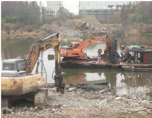
本报讯(通讯员包宏龙)12月14日,随着挖掘机将两侧边坡桥墩拆除,位于南通市江海河通州段“中新苏通”码头南侧500米左右的江海桥被全部拆除(见图,纪进摄)。拆桥施工单位现场负责人纪进说,该桥的顺利拆除,多亏了南通市交通运输综合行政执法支队和通州区交通运输局综合行政执法大队联手加强该水域航道管制。 据了解,江海桥建于20世纪70年代,为三跨拱桥,单跨40米,全长120米,桥宽6.8米。由于当时建设标准低,年代久远,加之使用率逐年增高,大桥破损严重,经技术检测部门检测被确定为危桥。随着北侧1公里左右南兴大桥和南侧1500米左右新江海河桥的建设,该桥已废弃多年。“作为通江达海的主要干线航道,江海河的五级航道
