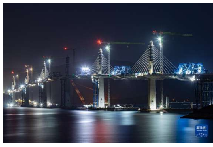
2021年6月22日在克罗地亚南部的科马尔纳村附近拍摄的佩列沙茨大桥施工现场。
