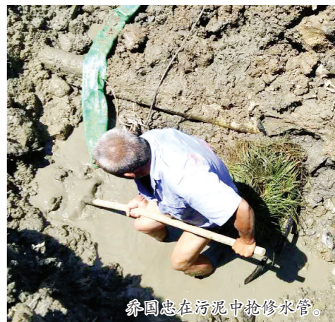
乔国忠在污水池中抢修水管。
