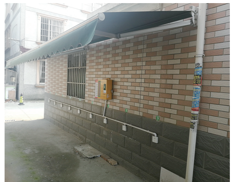
装有充电装置的雨棚。(沈卓琪摄)
