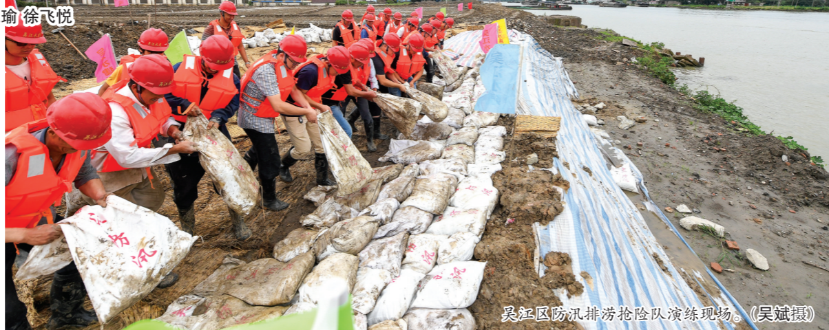
吴江区防汛排涝抢险队演练现场。(吴斌摄)
