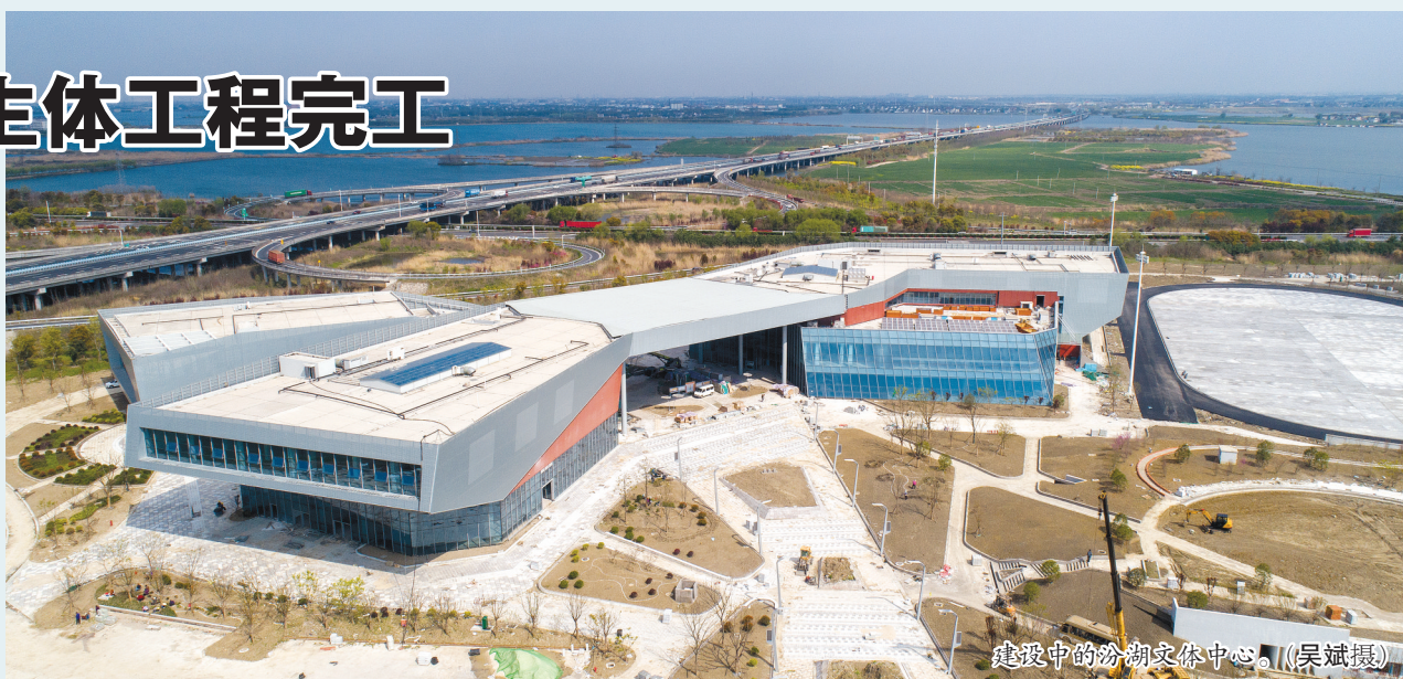
建设中的汾湖文体中心（吴斌摄）
