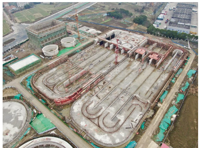
武南第二污水处理厂工程总投资约6亿元,目前实施的一期工程处理规模10万吨/天,已完成土建投资约1.7亿元,占土建总量的62.4%,超额完成年度目标任务。项目预计10月底进水调试,12月底整体完工,主要服务中心城区、高新区、前黄、礼嘉、洛阳等片区,服务人口超45万人,出水水质达地表IV类水标准。 吴梦婷 摄
