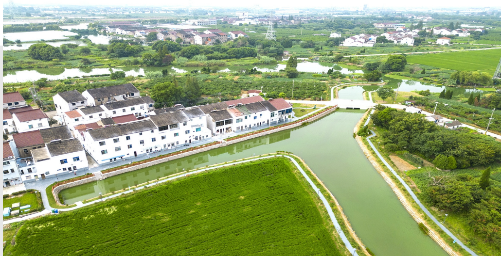
陆家头浜综合整治项目位于洛阳镇,为我区重点民生实事项目“吾优生态”工程之一。项目结合农村人居环境整治、水系连通及水美乡村建设、水生态治理等,对河道两侧全线河坡进行清杂整坡,新建生态护岸约700米,目前已竣工并通过验收。图为整治一新的陆家头浜。徐晶玮 摄
