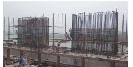
351省道车路河大桥抢抓工期,强力推进特大桥施工建设,6月29日,顺利完成了河北19#主墩两个水上承台的施工,共计浇筑混凝土480立方米。袁根祥 倪高江 摄
