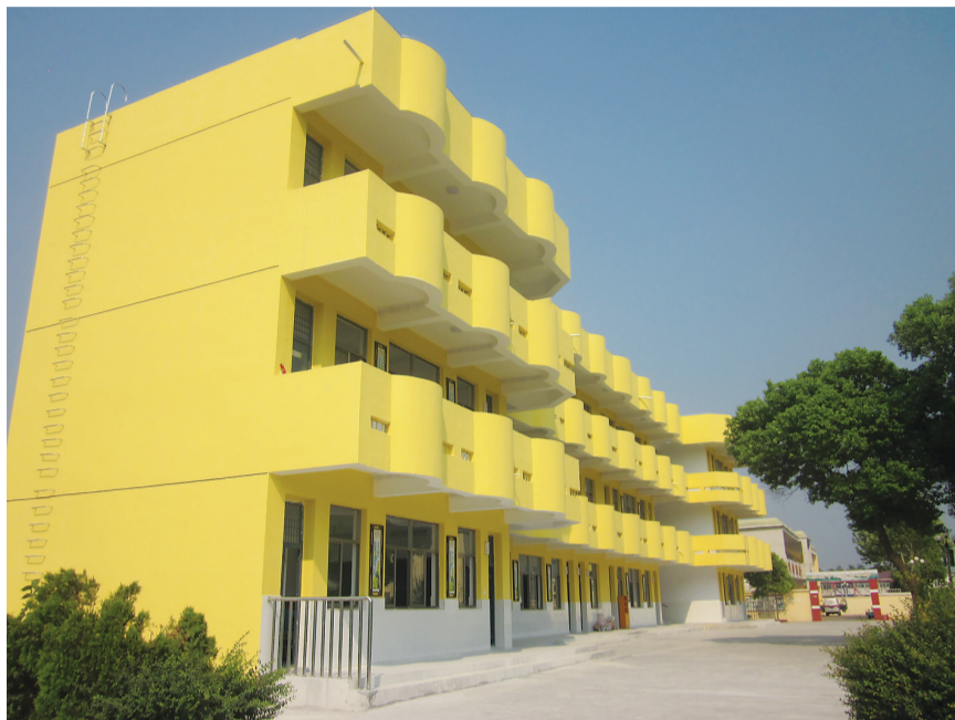
经过加固改造的虹顾中心校教学楼。
