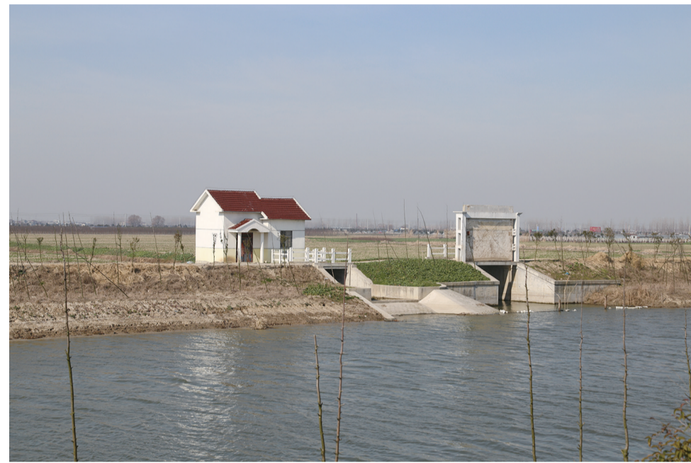
幸福河上的闸站。
