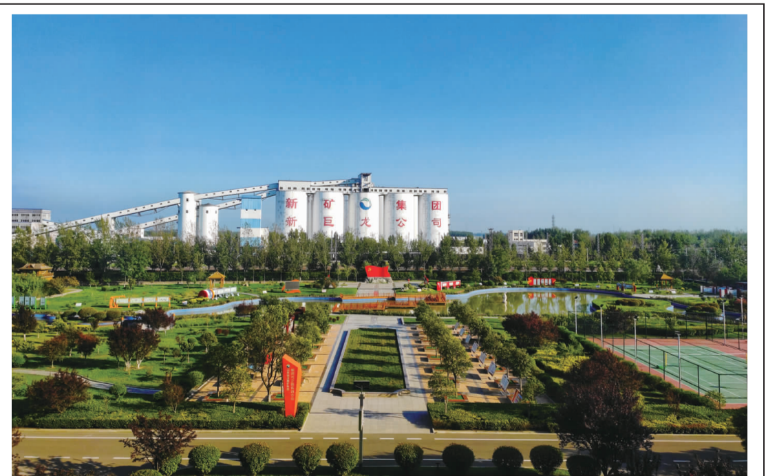
初秋的新巨龙花园式矿区，处处草长绿荫，整洁干净，漫步在矿区，很难与过去煤黑粉尘满地的煤矿联想在一起。作为全国绿色矿山建设试点单位，新巨龙大力推进绿色矿山建设，成为践行绿色循环矿山经济的先行者和排头兵。（臧东明 摄）
