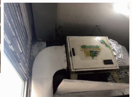
厨房油污已清理
