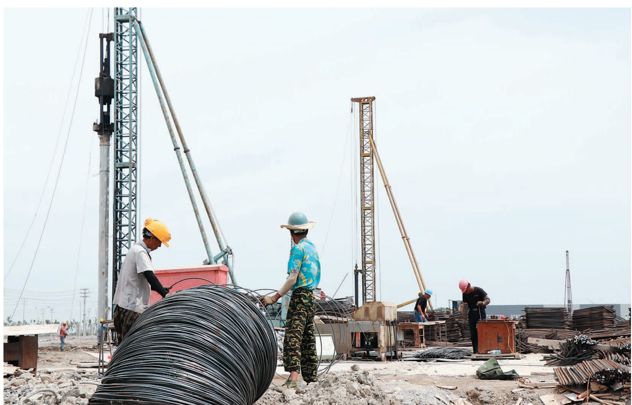
江苏龙尚重工有限公司是我县引进的冶金设备制造项目,主要产品为高效自动化连铸机、重载液压机机器人等设备,具有智能化程度高、精密度高等特点。项目投产后,将成为国内非标设备制造的龙头企业,进一步推动我县金属新材料产业链做大做强。当前,该项目建设工作已全面展开。 记者 黄玉娟 摄
