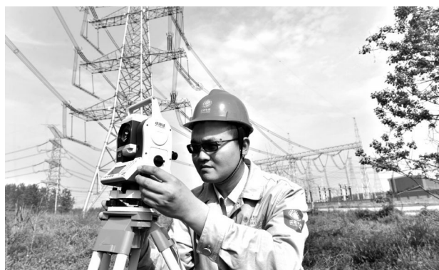
近日,供电公司人员在秦湖镇范墩村用经纬仪定位新上10千伏线路走向。据悉,该公司在配网工程管理中,严格落实精细化管理模式,从线路勘察、定位、建设到工程质量、验收、投运,实行跟踪监督,确保投资科学、布局合理、管控规范。 通讯员 张友情
