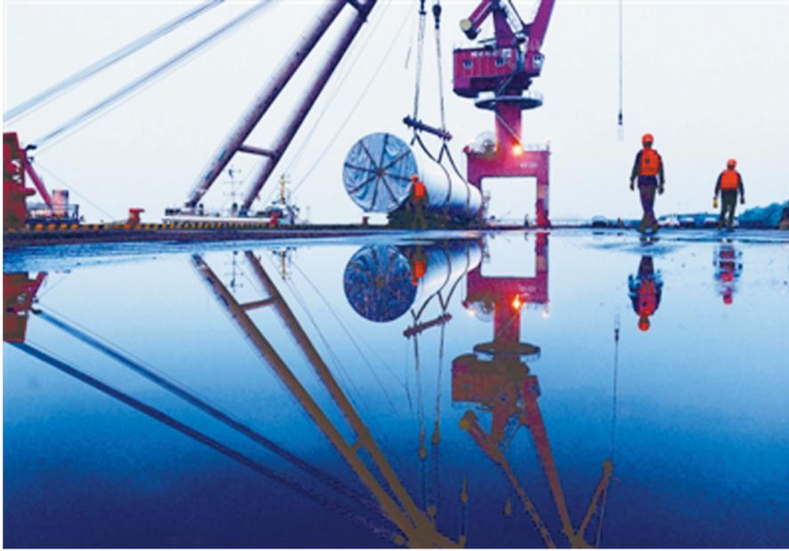
日前,中建安装集团中建五洲公司制造的海上风电塔筒从南京吊装。这是该公司为上海临港海上风电项目制造的首个海上风电塔筒,装机容量6兆瓦,总重400多吨,高95米。
