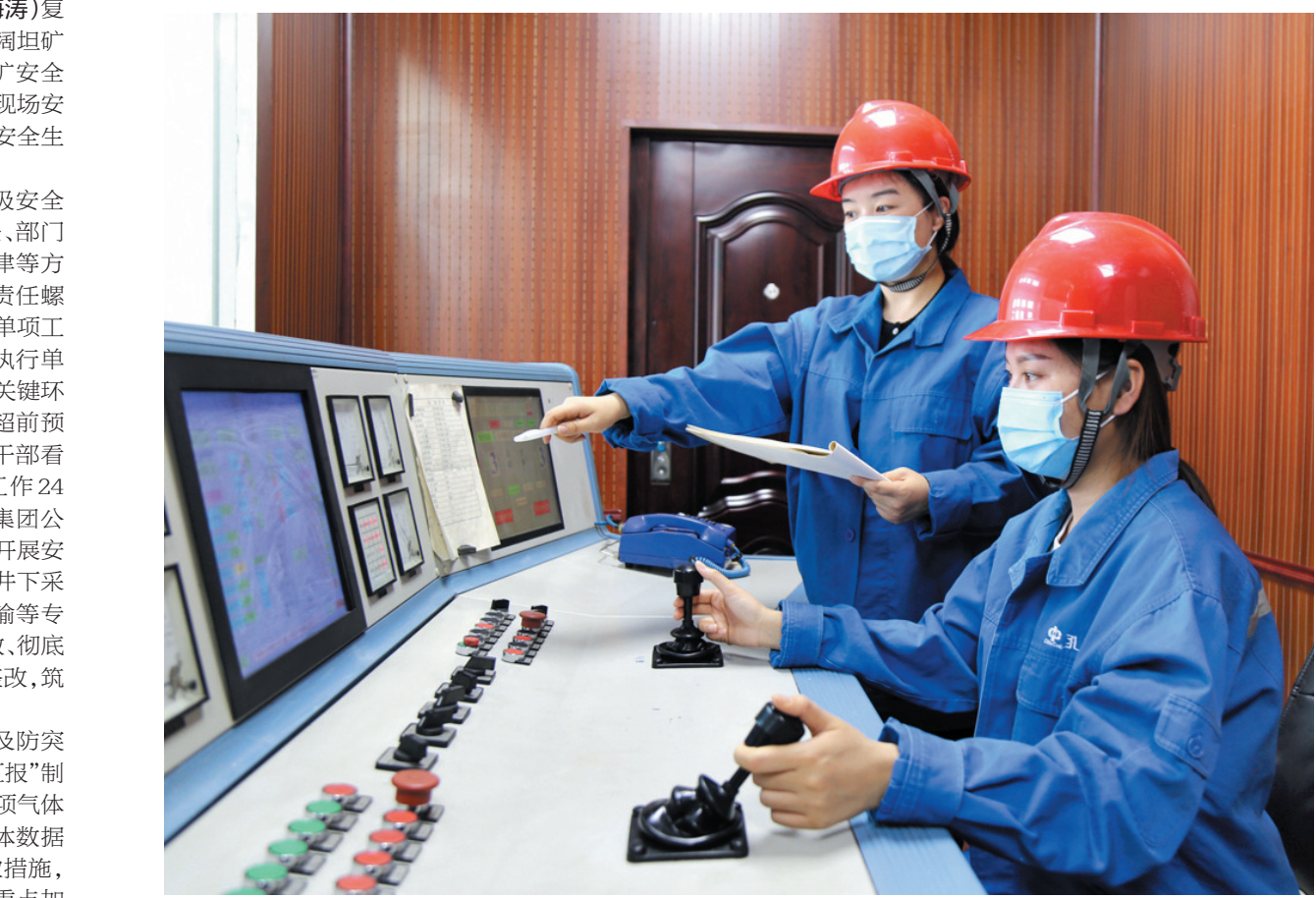
疫情防控期间,中煤大屯煤电公司孔庄矿绞车房女工坚守岗位,认真操作,积极做好个人防护,严格遵守作业规程,保障设备安全可靠运行。图为该矿绞车房女工在认真作业。
