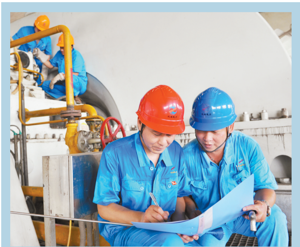
在安全生产隐患“大排查大整治”专项行动中,供电公司本着“谁检查,谁签字,谁负责”的原则,强化排查整改,把工作做细做实。
