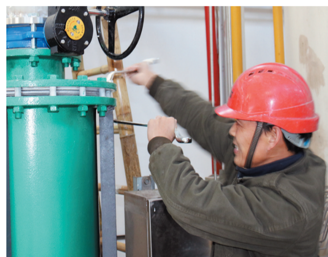
为保障化学水处理系统扩容改造工程有序进行,徐矿综合利用发电公司严格按照节点计划稳步组织施工,为大幅提升效益打下良好基础。图为该公司职工在安装工程所需树脂捕捉器。 本报记者 陈霖 摄
