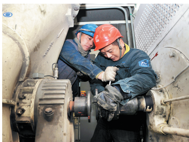
为确保设备安全运行,华美热电公司开展安全巡查整改工作。图为该公司技术员检修发电设备。
