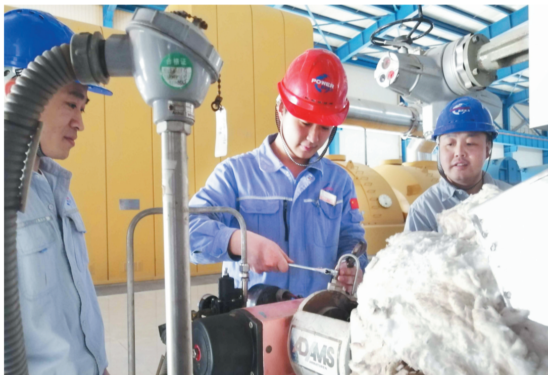
针对华德电厂人员不足、备件短缺、任务繁重情况,华美热电公司驻伊拉克华德电厂中方技术人员不仅为当地员工进行技术培训,还负责日常巡检和维修工作,确保安全生产。图为该公司技术人员在五号机组临时停机时处理二级抽汽逆止门故障。 通讯员 王玉瑶 李振恒 文摄
