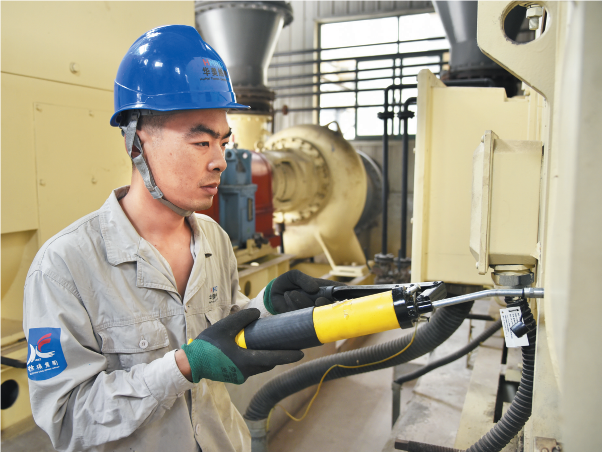
入夏以来,华美热电公司积极开展机组对标管理,狠抓设备稳定运行及调频备用在加强定点专项巡查的基础上,着力加大重点设备巡检力度,全力保障安全生产。图为该公司工作人员在为浆液循环泵电机加注润滑油。
