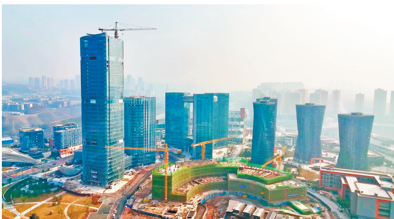
仙桃数据谷三期项目顺利推进 本报记者 陈亦鸣 摄
