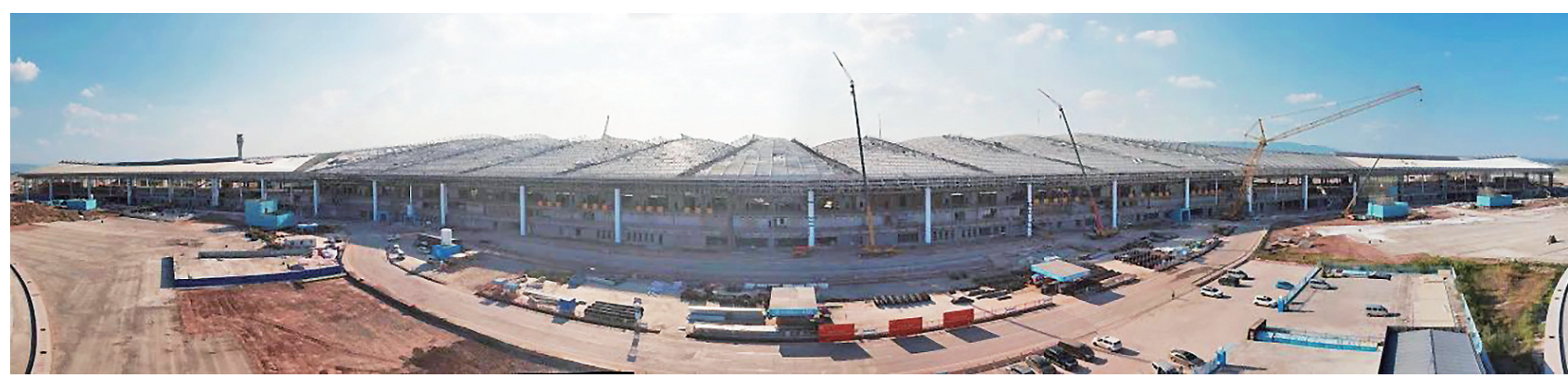
江北机场T3B航站楼施工现场 本报记者 朱云卿 摄
