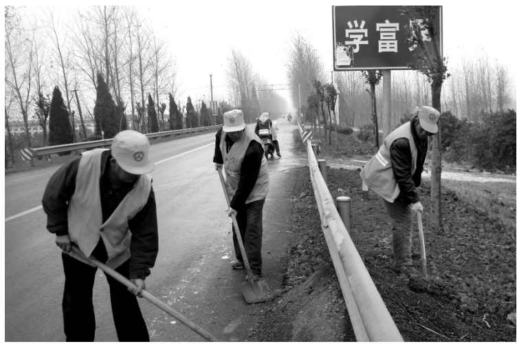
为了确保辖区内路桥在冬季雨、雪天气行车安全,连日来,区公路站组织养护人员对干支线路的高桥、急弯、陡坡等处配备防滑材料60余吨,堆放在指定区域,以防突发事件。(仇金留 摄)
