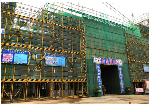
潘黄小学、初中项目是市、区两级政府为民办事实重点工程,由高新区潘黄街道投资建设。学校位于开创路西、鹿鸣路北、潘黄路东,跃进河南,占地137.43亩,建筑面积60042平方米,可容纳中小學生3000多人。截至目前,土方回填工程已经结束,小学部西楼正在进行钢管排架搭设。图为施工现场。
