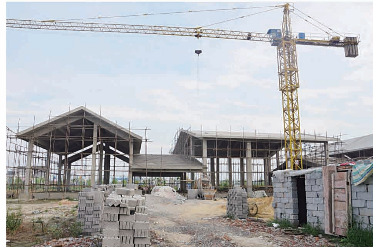
总投资820万元的郭猛镇杨侍村村史馆项目,占地2000平方米,于去年12月份开工,馆内将设有书画、农民生产生活生产工具等展区,全方位展示农村不同时期的发展面貌。目前,该馆主体结构已经完成,预计今年年底建成并对外开放。图为施工现场。
