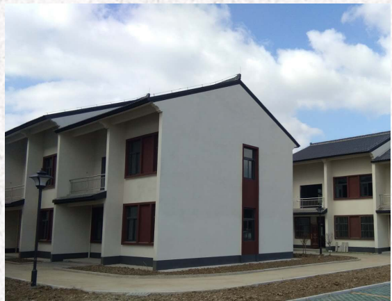
正在建设中的集中居住点
