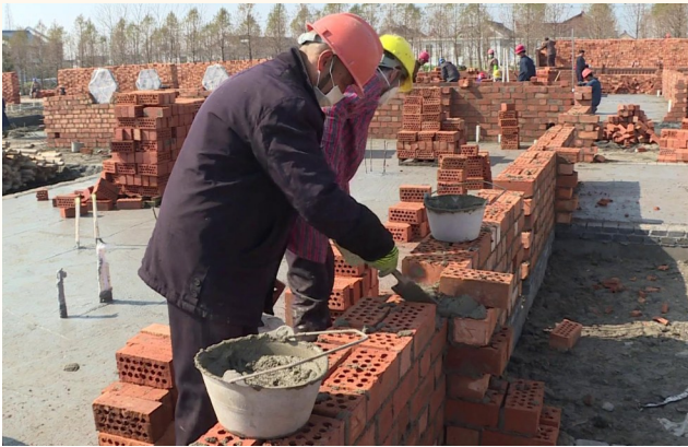
图为大冈镇佳富村新型农村社区施工现场
