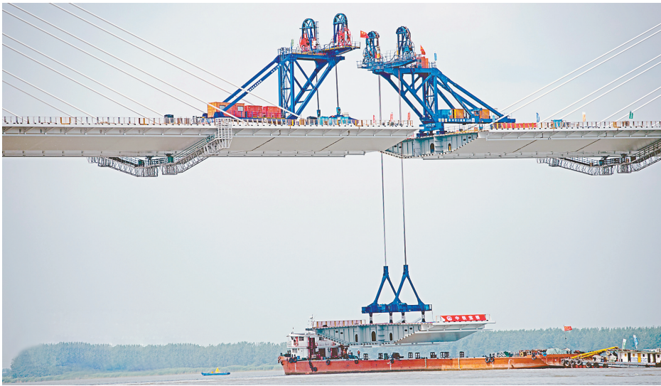
6月7日上午，南京长江五桥最后一块桥面顺利吊装完成，具备合龙条件。（来源：人民网）
