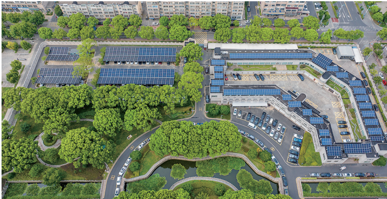
市机关大院北侧停车场分布式光伏设施 任广真 摄
